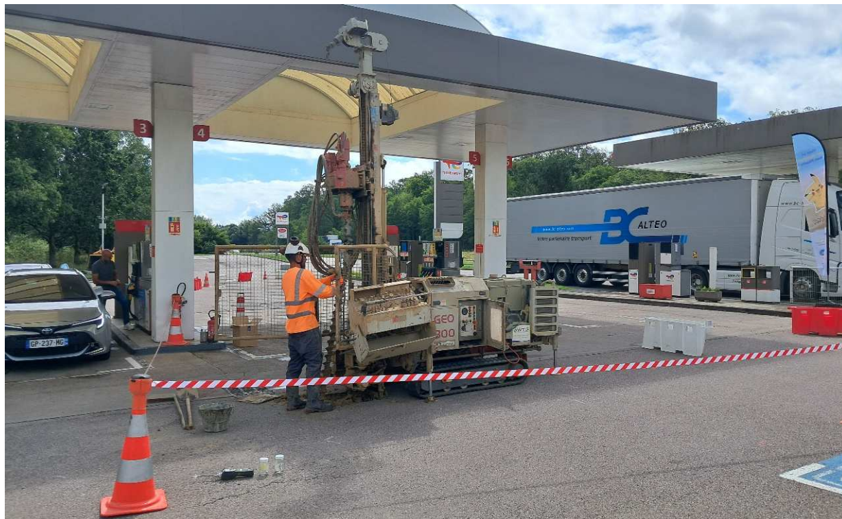
Réalisation des sondages à la tarière mécanique (ici S9)
