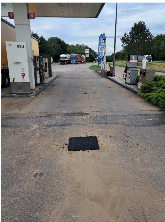
Illustration après réfection (sondage S1)
