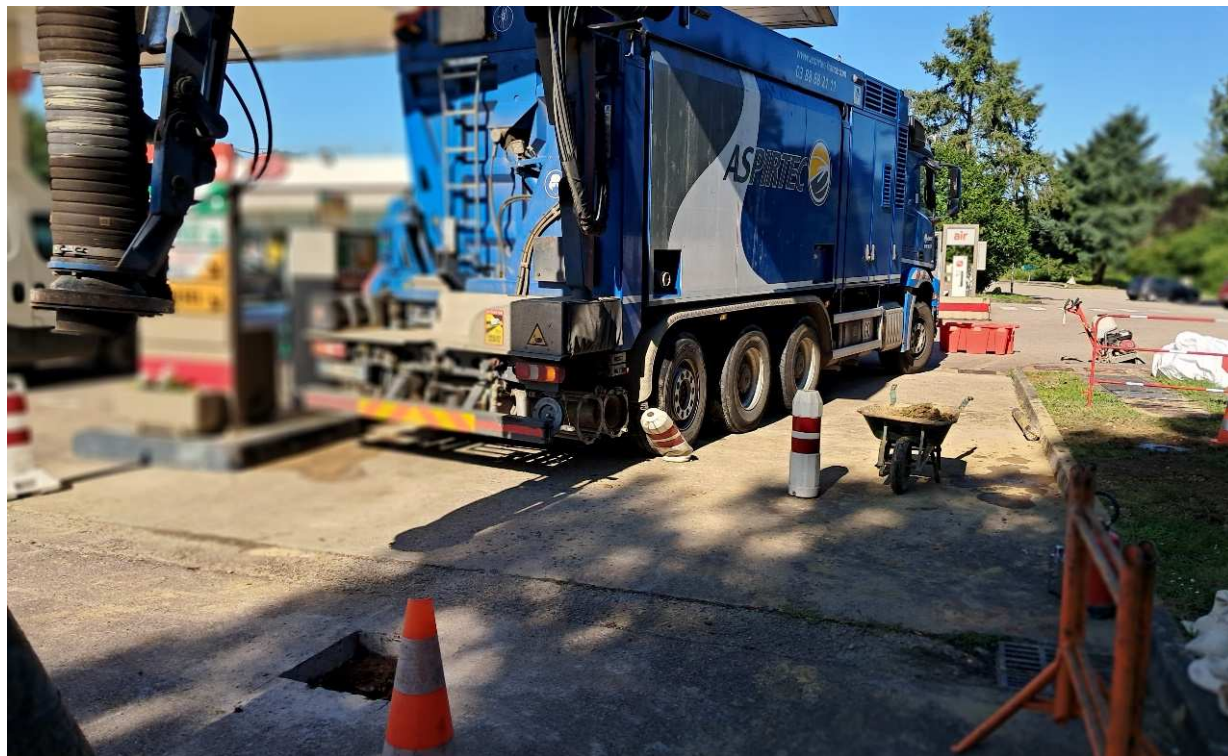
Réalisation des avant-trous à l'aspiratrice
